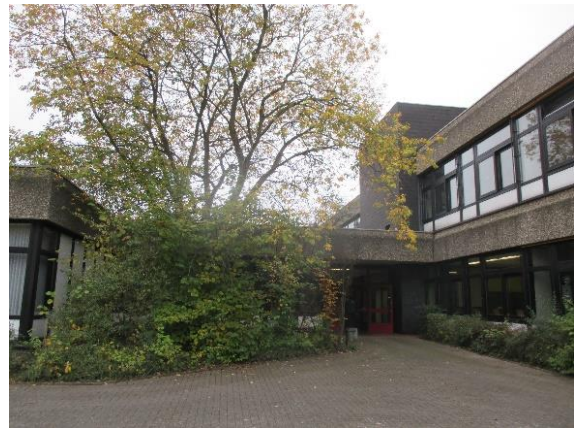
Förderschule Kiefernweg Stadt Laatzen (Bestandsgebäude)
